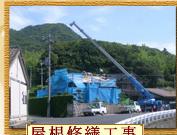
屋根修繕工事
