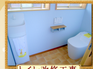
トイレ改修工事
