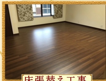
床張替え工事
