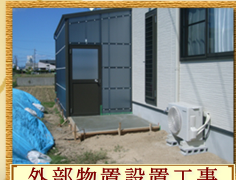
外部物置設置工事
